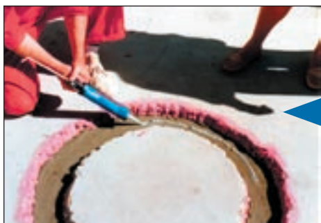
5. Aplicar un cordón de LEAKMASTER de modo continuo sin interrupción en el lugar a sellar.
