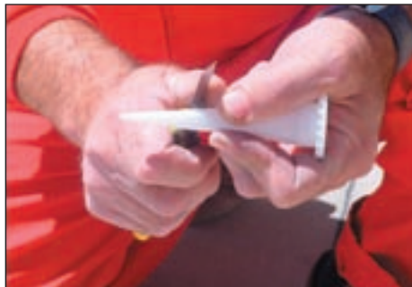
2. Cortar el extremo de la boquilla en diagonal a la distancia apropiada.
