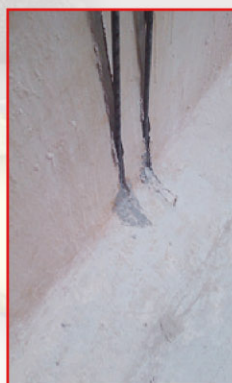
Fissaggio delle barre alla lastra con MAXFIX® E .
