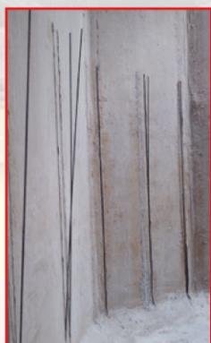
Preparazione e reimpostazione del rinforzo con DRIZORO® CARBOROD .
