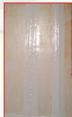
Impregnazione delle barre con MAXEPOX® CARBOFIX .
