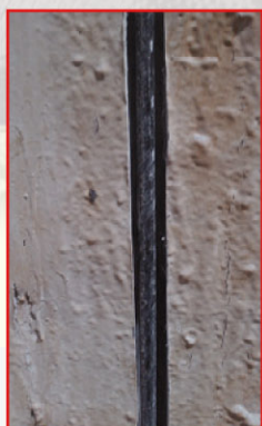
Collocazione della barra all' interno dell' incassatura.
