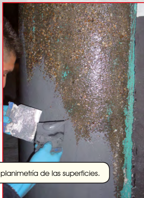
Saneado del hormigón deteriorado, eliminando la superficie degradada.
