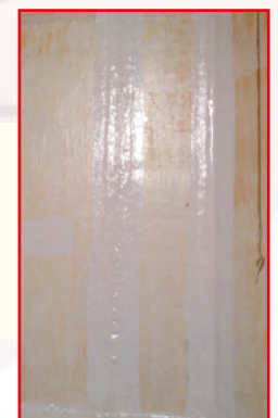
Embebido de las barras con MAXEPOX® CARBOFIX .
