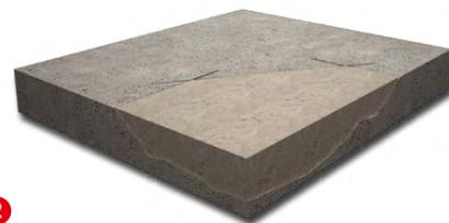
**2** Aplicar el mortero de parcheo **MAXPATCH<sup>®</sup> MC** de resinas de metacrilato.
